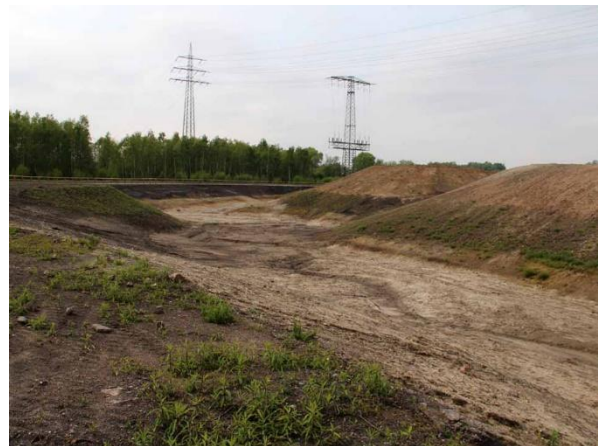
Abb. 2: Lämpkes Mühlenbach unmittelbar nach der Modellierung (Oberhausen, 04.05.2017, C. Buch).
